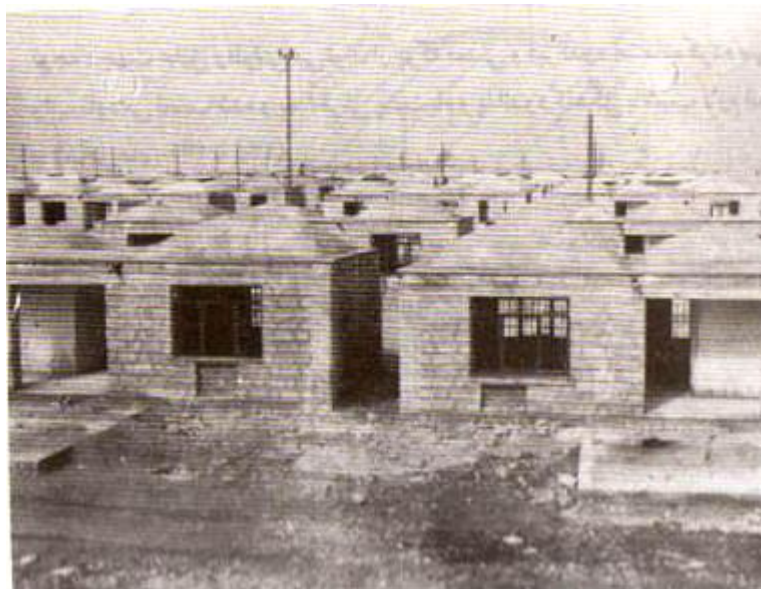
اجرای پوشش طاق نیم‌گرده پوش
